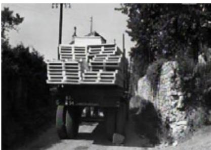
*A solução para a nova cobertura, necessária pela falta de meios, veio de um produto que apareceu no mercado nesse momento. Eram grandes chapas de madeira compensada que conformavam uma superfície hora flexível, hora rígida e que mediam 13 metros de comprimento e exatamente 1 metro de largura, uma feliz coincidência com a modulação que já havia sido adotada na casa.*
